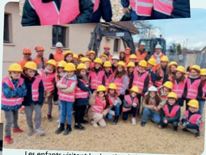
Les enfants visitent le chantier de l'aménagement du parvis avec l'entreprise Colas
